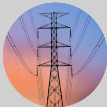
ENERGIETECHNIK INKL. ZÄHLER, MESS- UND PRÜFGERÄTE
